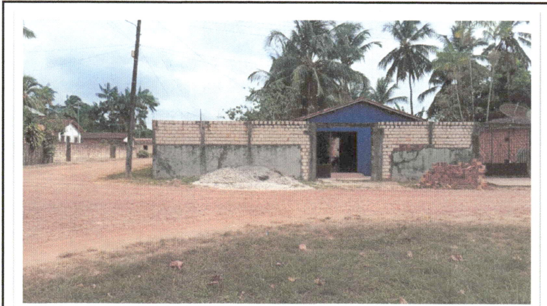
Foto 01: Vista principal do prédio.
