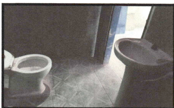
Foto 04: Vista do banheiro com piso e revestimento cerâmico.
