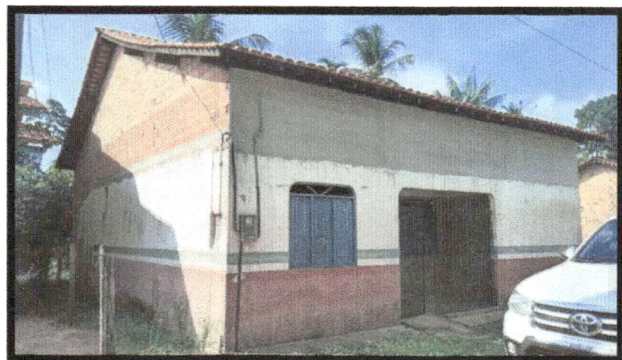
Foto 01: Vista principal do prédio
