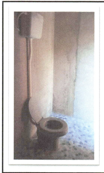
Foto 03: Vista do banheiro.
