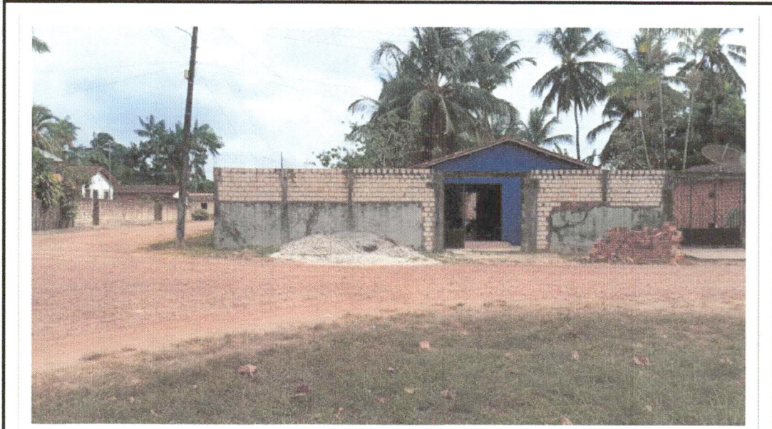
Foto 01: Vista principal do prédio.
