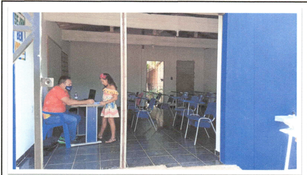
Foto 02: Vista da sala de aula com piso cerâmico e sem forro.
